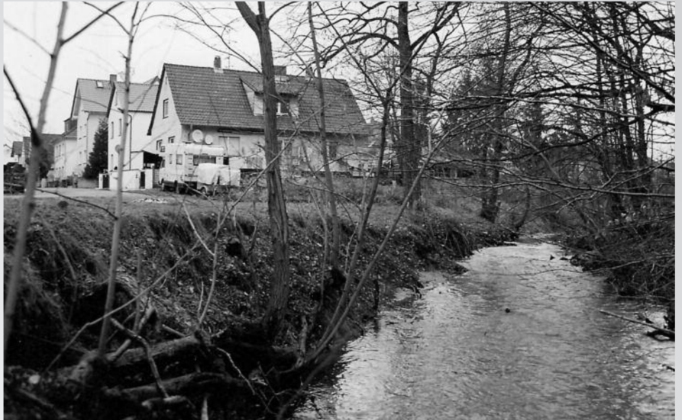
Hier am Schleifmühlengeweg rückt die Hochwasserlinie durch den Verbau der natürlichen Retentionsräume des Hegbachs bis an die Grundstücke heran.
