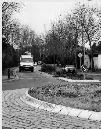
Für die Nordumfahrung sind am Vitrollesring in Mörfelden Lärmschutzmaßnahmen notwendig.
