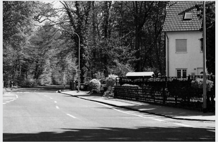
Gigantisch: Am Ortsausgang Richtung Gräfenhausen wird das Bauwerk mit der Straßentrasse, den Dämmen, Auffahrten und Wällen eine Breite von 140 m haben.
